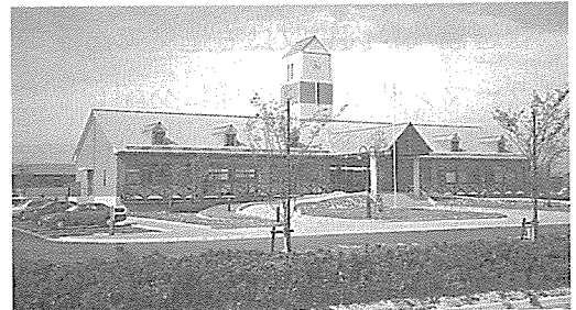
家畜改良センター熊本牧場庁舎全景(玉名郡横島町)
